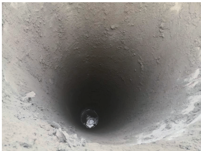
图 8 回填水泥土
