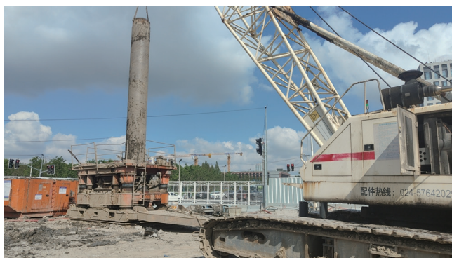
图 7 套管拔除
