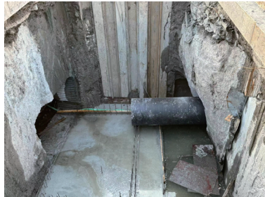
图 10 迁改管道安装
