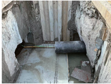
图 10 迁改管道安装
