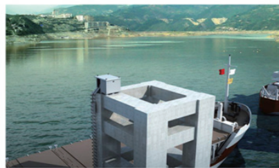
主要适用于靠船墩锚地 (升降式岸电)
