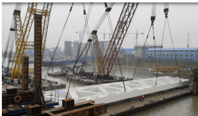
图 9 主桁梁节段吊装施工
