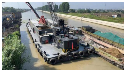
图5 水上混凝土搅拌船施工
