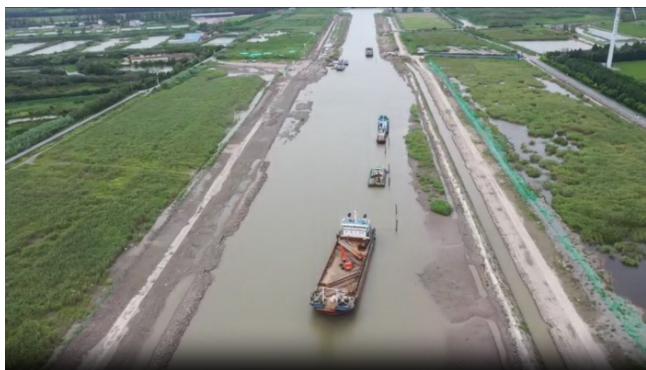
图 8 无人机巡视船舶避风落实情况
