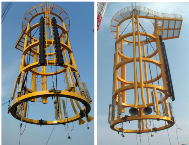
图 2 集成式附属构件起吊
