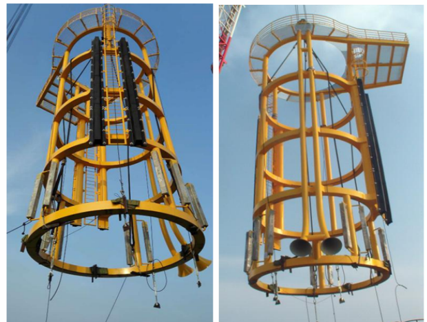
图 2 集成式附属构件起吊
