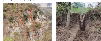
图 3 张家湾岸卸荷裂隙和探槽照片
