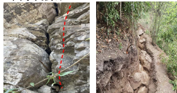
图 2 百兴岸卸荷裂隙和探槽照片
