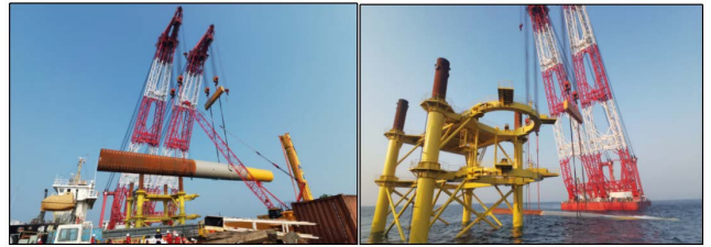
图4 单桩抬桩入水
