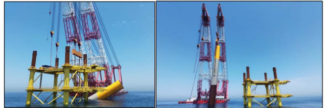
图5 单桩翻桩 图6 翻桩完成
