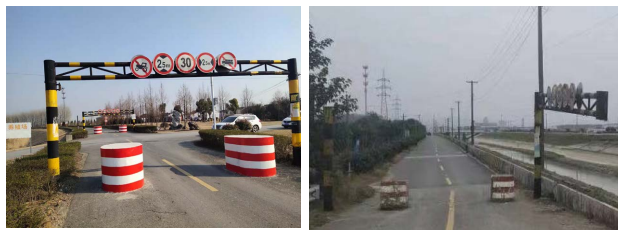
图1 限宽路墩和限高杆现状
