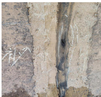
图1 检查后需修补的止水带
