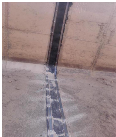
图5 钢带加固后的拱渡渠伸缩缝止水带
