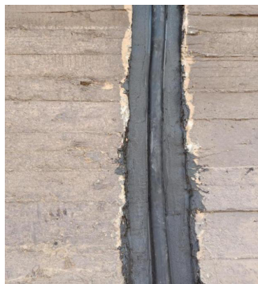
图4 粘贴完成的渡槽伸缩缝止水
