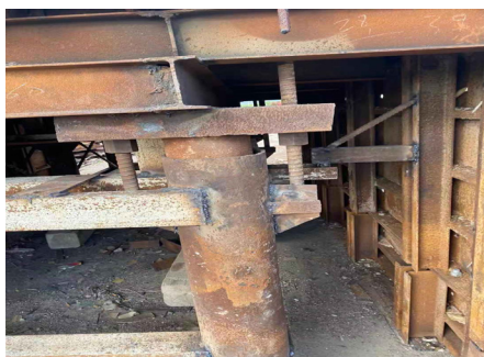
图2 丝杠临时支撑系统
