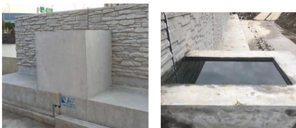
图6 闭水试验现场实景图
