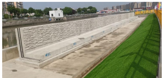
图5 “首件制”现场拼装试验段
