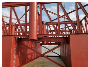
图7 浮箱平台制作现场照片
