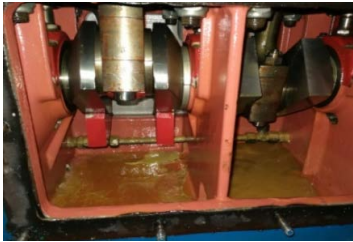
图 1 空压机滑油乳化情况
