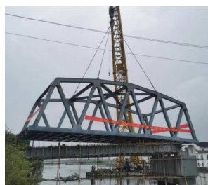
图 7 钢桁架主跨吊装图
