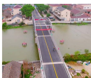
图 8 桥梁改造完工图
