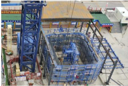
图3 钢筋网片现场组拼
