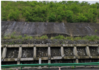
图 1 运营期第 1 次处治完成后边坡形貌
