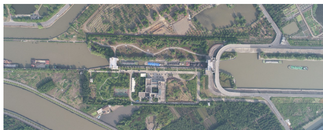
图 1 新坝船闸航拍图
