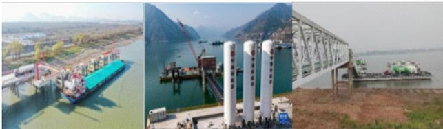
图 1 罐车加注（左）、岸基加注（中）和趸船加注（右）
