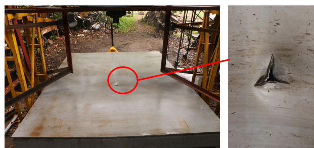
图6 增强型甲板板架结构冲击失效变形
