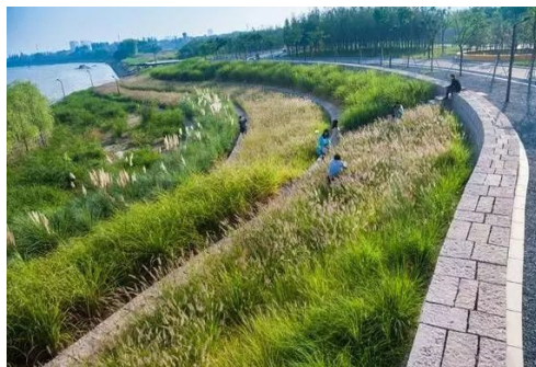
图5 植被复垦工程
