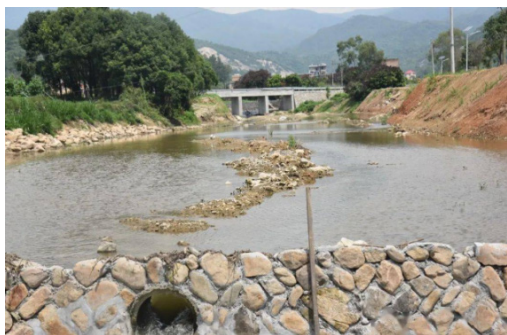
图3 河道岸坎的开挖
