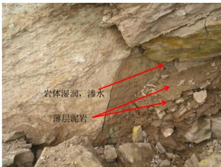
图 6 桩身剪断处薄层泥岩
