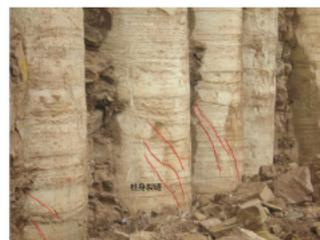
图 1 桩身剪切裂缝
