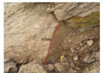
图 2 BZ31# 桩身剪切裂缝
