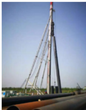
图 2 钢管桩起吊作业
