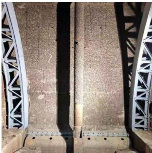
图3 现场改造应用
