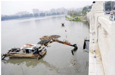
图 1 航道的疏浚工作
