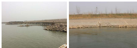
图2 戴家洲右缘护岸护底处损毁
