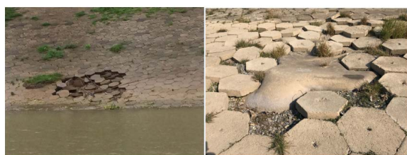
图8 戴家洲水道戴家洲右缘护岸人为破坏区
