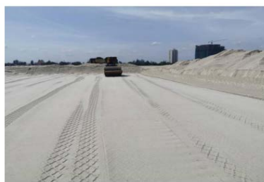
图2 砂围堰及后方碾压
