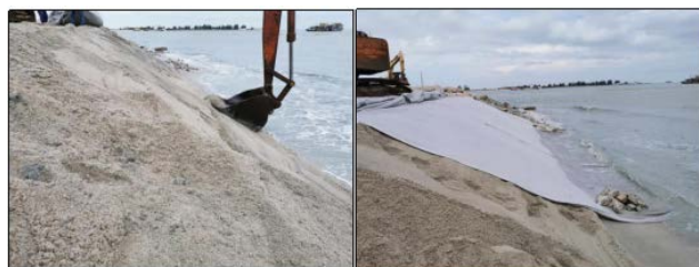
图3 护岸砂坡拍实及防护
