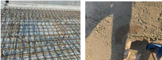
图4 底座板防裂网片安装
