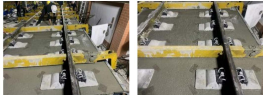
图5 轨枕四角防裂网片安装
