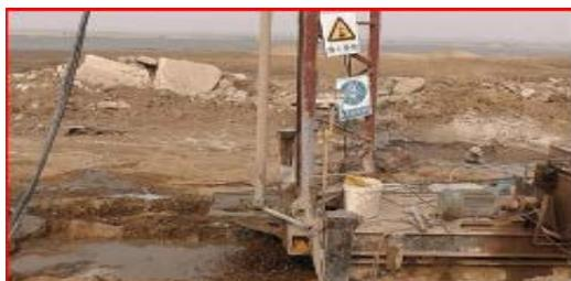
图6 压密注浆施工图
