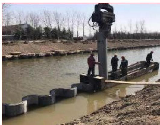
图3 导向定位、打桩
