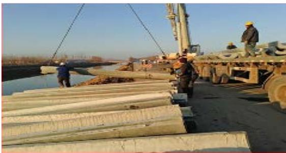
图2 波浪桩卸货图
