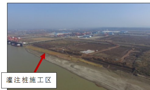
图 1 嵌岩灌注桩施工现场
