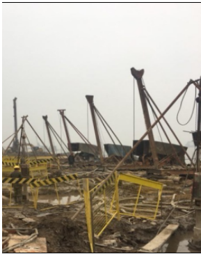
图4 冲击钻施工
