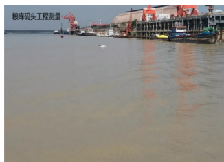
图2 粮库码头工程测量
