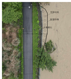
图 4 利用沿江道路修建下水点
