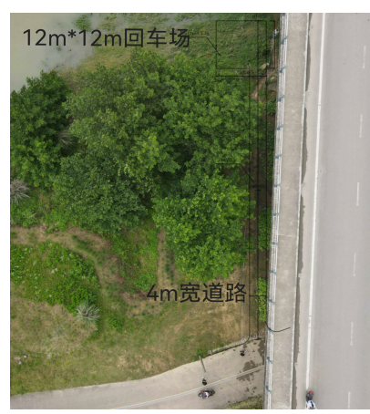
图 6 靠近桥梁建设下水救援通道
