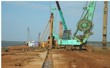
图 1 围堰施工图
