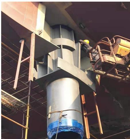
图 1 舵套筒船坞散吊搭载定位 (传统工艺)
