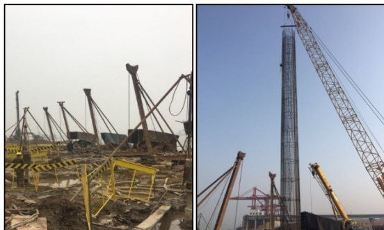
图4 冲击钻施工
