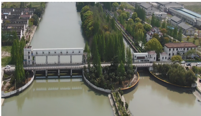
图 1 枢纽现状照片
