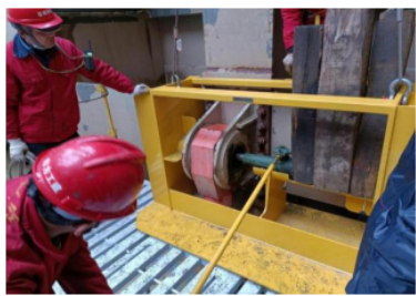
图 10 联门轴拆轴工装现场应用测试
