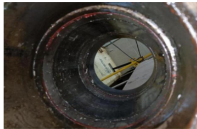
图 11 联门轴拆除后现场照片
