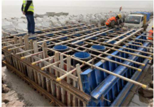
图4 波纹管安装
