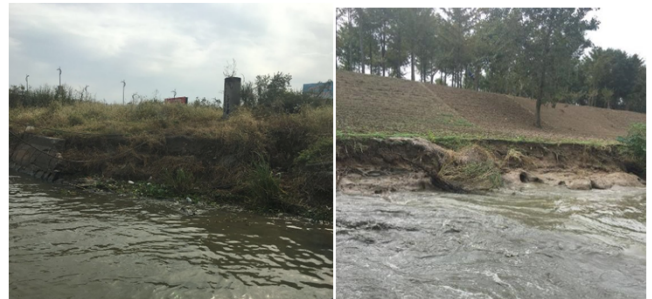
图2 现状岸坡情况
