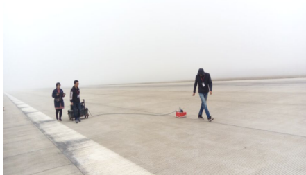
图 2 地质雷达检测现场
