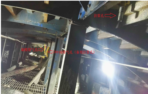
图 5 台车顶模注浆孔位置
