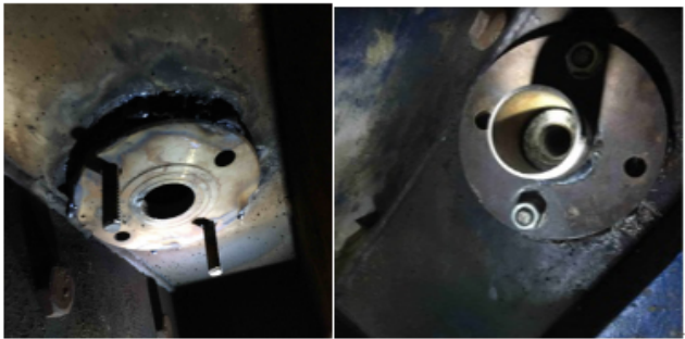
图 6 焊接注浆孔固定法兰 图 7 法兰及注浆连接接头安装
