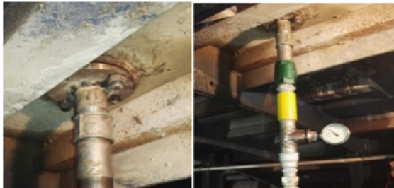
图 8 固定 RPC 注浆管
