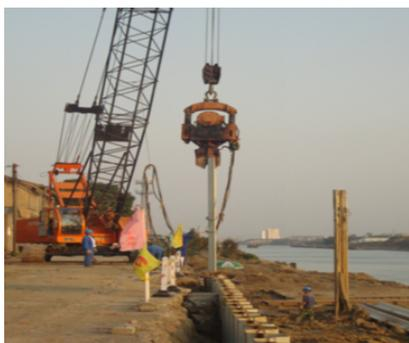
图3 现场钢板桩施工
