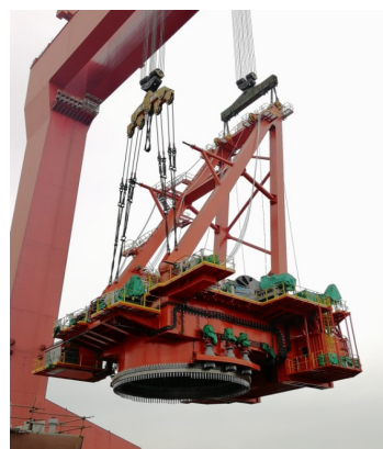
图 3 安装 1200t 起重机回转平台和 A 支架
