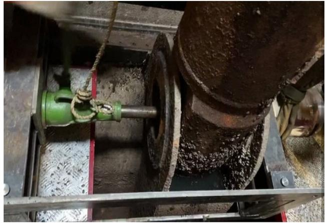
图 12 某大型船闸反弧门联门轴拆卸
