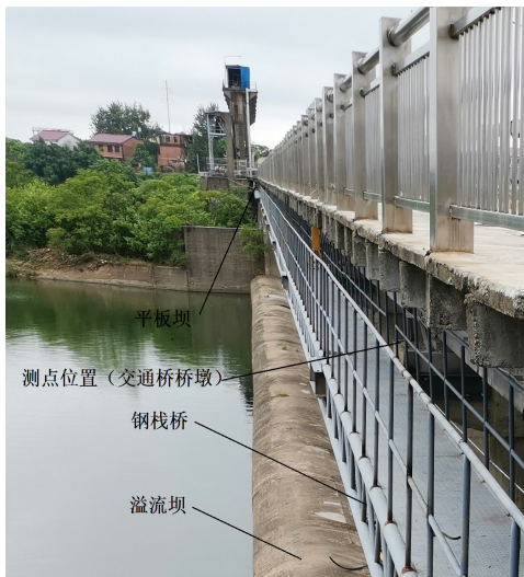
图4 钢栈桥布置现场照片
