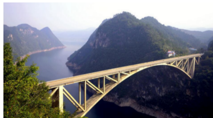
图4 桁架拱之桁式组合拱(江界河大桥)
