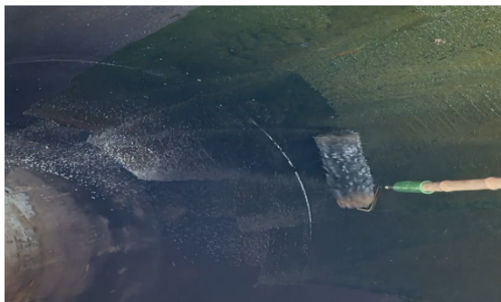
图 10 护筒涂刷减摩剂
