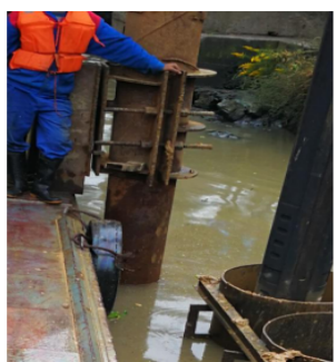
图9 加装抱箍装置
