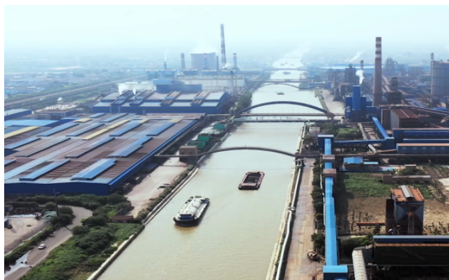
图1 某航道整治护岸工程
