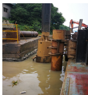
图8 加装抱箍装置
