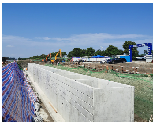
图 1 整体箱式装配护岸
