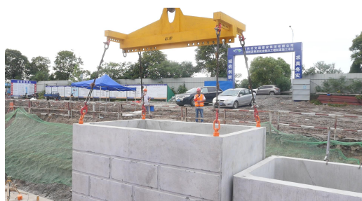
图 6 复核空箱安装位置
