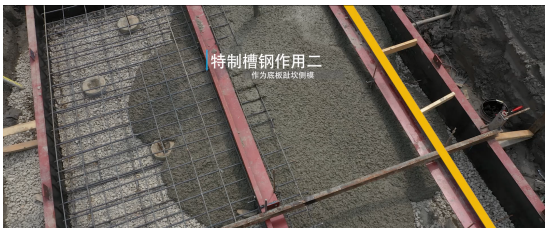
图4 特制槽钢作为底板趾坎侧模
